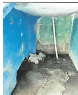
Foto 6: REPARACIÓN DE RED DE DRENAJES Y RED DE AGUA POTABLE
