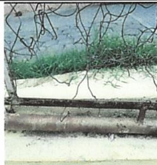
Foto 4: CERCO O MURO PERIMETRAL
