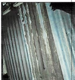
Foto 1: CUBIERTA DE LAMINA
