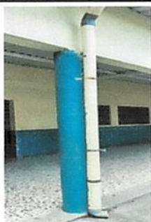
Foto 3: CANALES Y BAJADAS DE AGUA PLUVIAL
